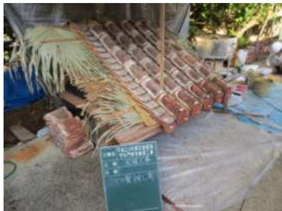
写真 2-5 クバの葉を使用した瓦葺き
