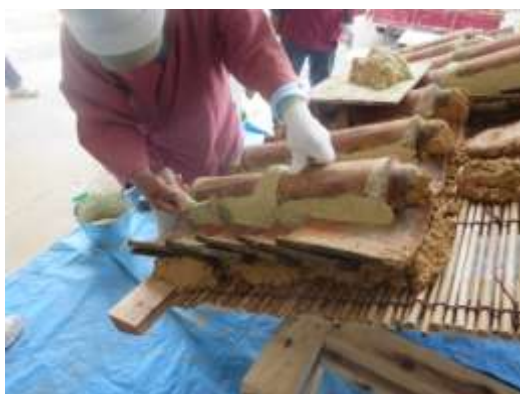
写真 2-15 赤瓦葺きの様子
