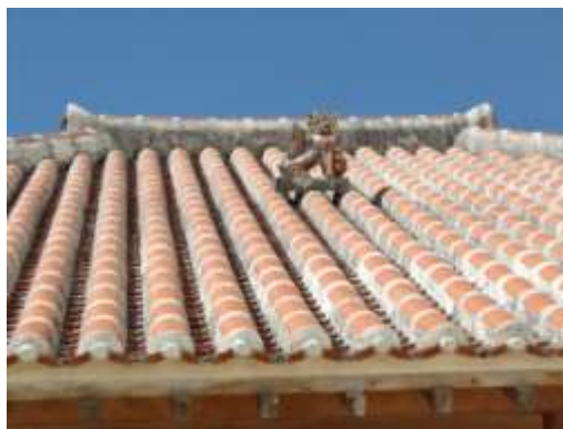
写真 0 - 2 赤瓦葺きの屋根
