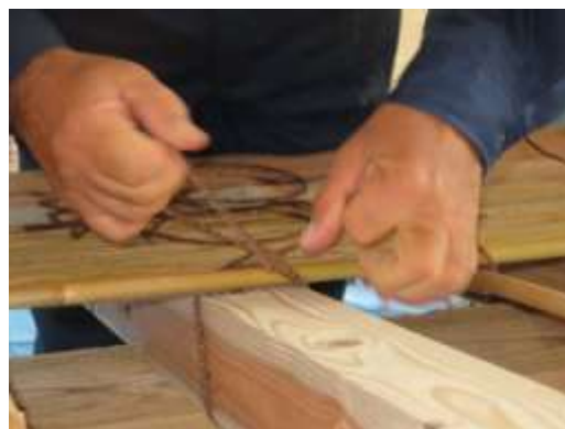
写真 2-14 野地竹編みの様子
