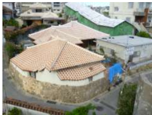
写真 2-3 主屋・作業場完成時の様子
