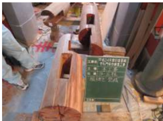
写真 2-4 柱根継ぎの様子
