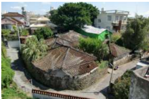
写真 2-2 着手前の新垣家住宅
