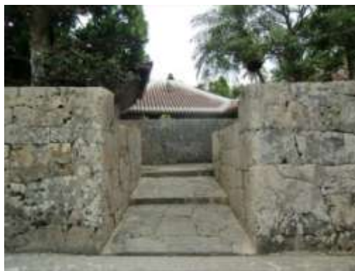
写真 0-3 - ヒンプンと屋敷囲いの石垣
