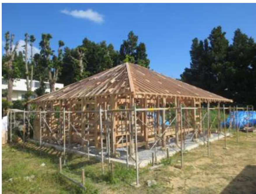
写真 2-19 構造見学会の現場。建て方が完成した民家
