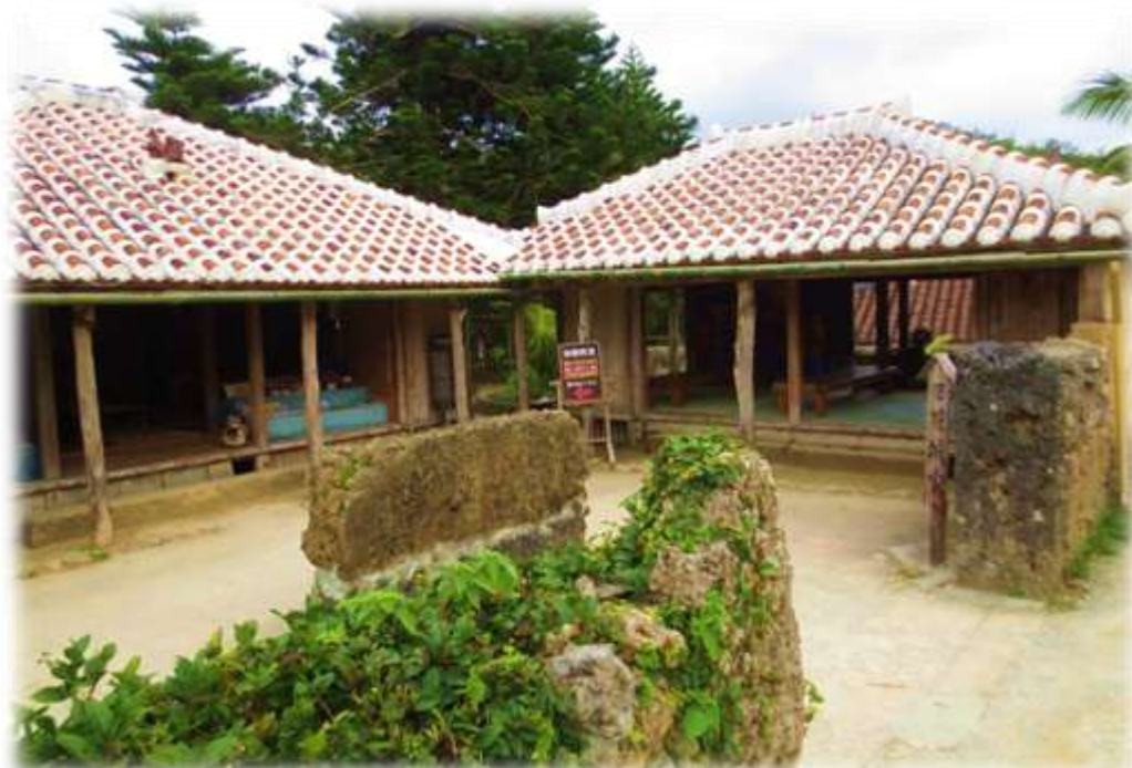
写真 0-1 伝統的な民家形態
