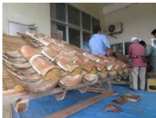
写真 2-16 赤瓦葺きの様子
