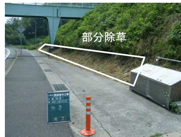
通行支障箇所のみ除草
