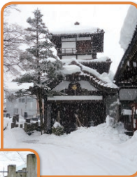
景観指定建造物。御三階は江戸後期(文政元年以前)の建築。明治3年に会津若松城本丸より移築。木造3階建だが、内部は4層で中3階がある。密議所または迎賓館的な使われ方をしていたといわれる
