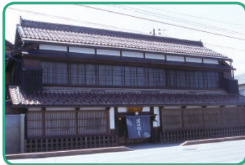
8 澁川問屋 景観指定建造物。創業は明治初年で、店舗は大正時代に建築。(詳細不明) 木造2階建の和風建築。山国の会津の食文化に欠かせない干物を一手に扱っていた
