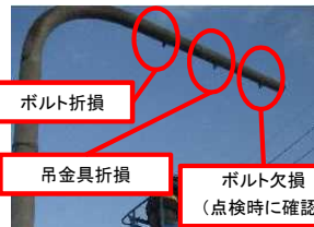
中央部吊金具折損
