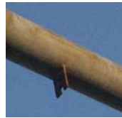
中央部吊金具折損
