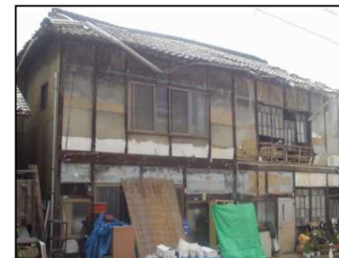
長期間人が住んでいない空家
