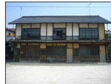
窓が割れ、放置されている空家
