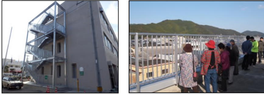
図5-1-11 (左)屋外避難階段の設置例(日和佐合同庁舎)(右)住民見学会の開催(同左)
