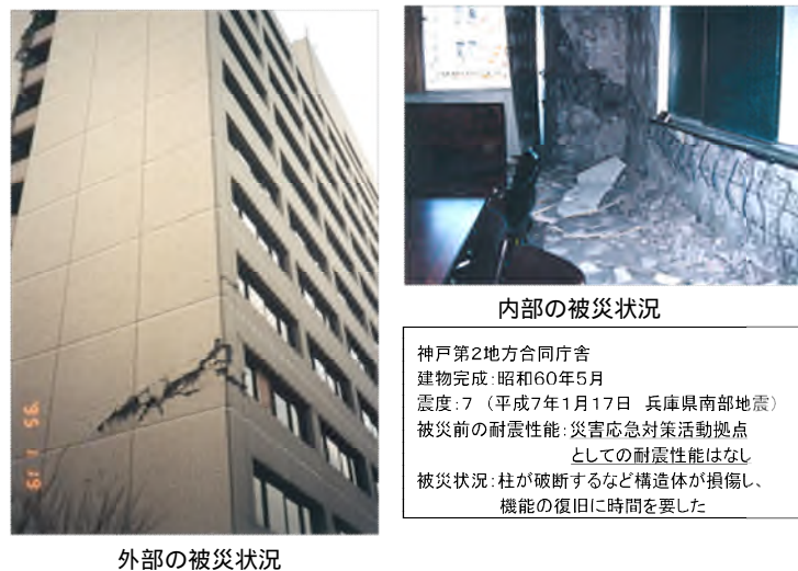
図 5-1-2 阪神・淡路大震災における建築基準法に基づく耐震性能を満たしている建物の被害事例
