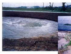
伊良湖サイフォン漏水状況
