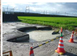
漏水による排泥工周辺陥没状況
