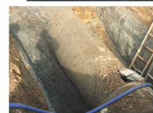
漏水箇所の状況 漏水箇所を掘削したところ、PC鋼線が破断し、管体が破裂していることを確認した。
