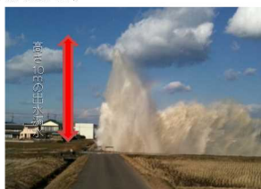
漏水状況 農業用水通水停止の他、町道の陥没及び水田の冠水被害(10m×30m)が発生した。
