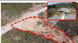
排水不良に起因する法面崩落
