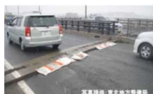
地震時の段差
