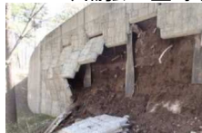
補強土壁の損傷
