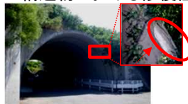
アーチカルバートの損傷
