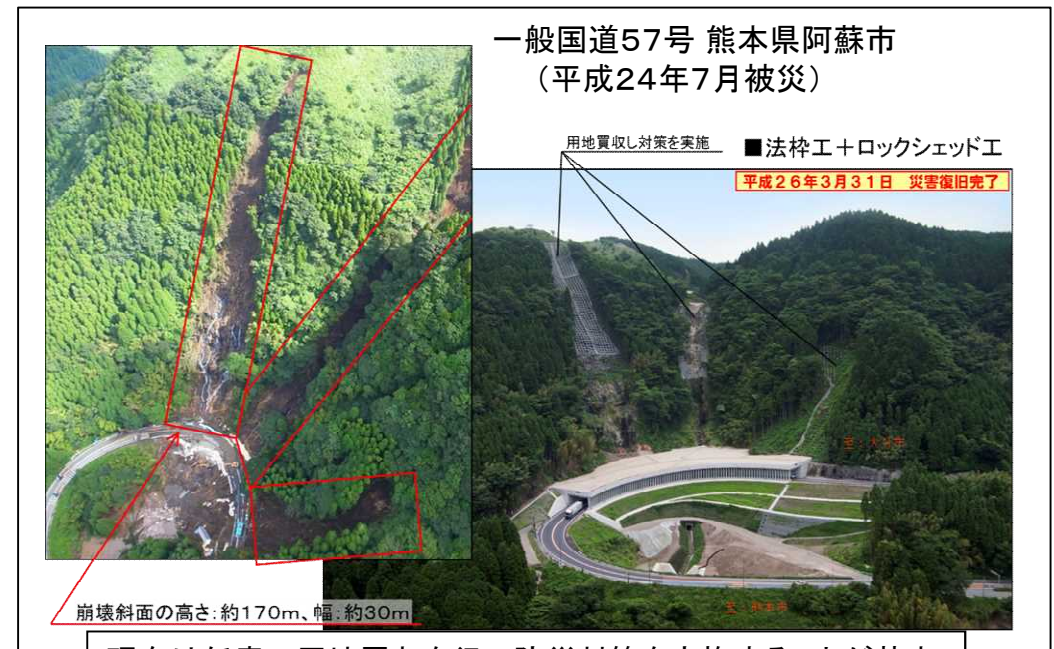
道路の区域外からの被災事例
