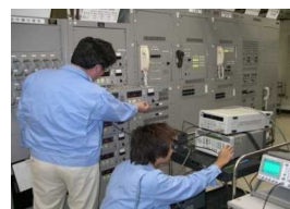
（航空保安施設点検実施状況）
