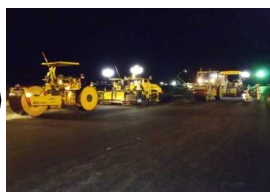
（老朽化した滑走路舗装の改良）
