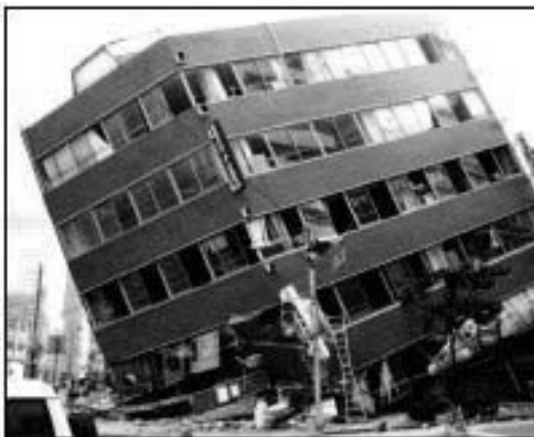
事務所ビル1, 2階の崩壊
