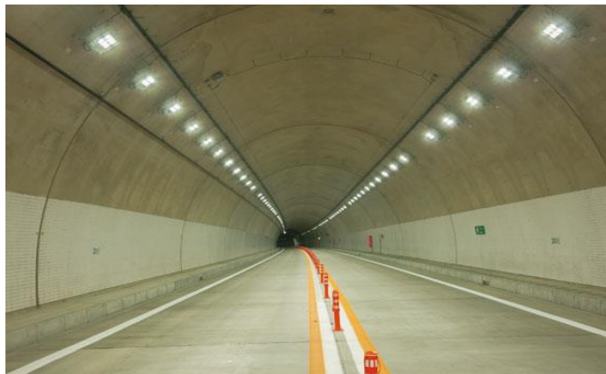
トンネル入口部照明の施設例
