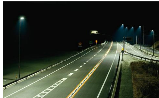
高速自動車国道の道路照明の施設例
