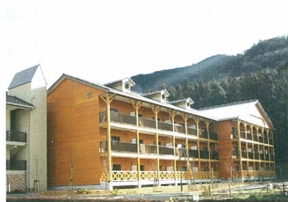
🌲 兵庫県多可町 県営八千代下野間住宅(住宅事業)
