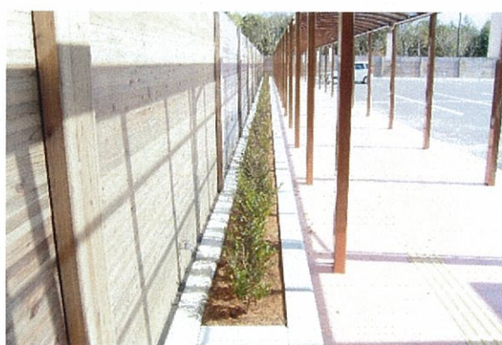
一般国道42号道の駅木製遮音壁（道路事業）
