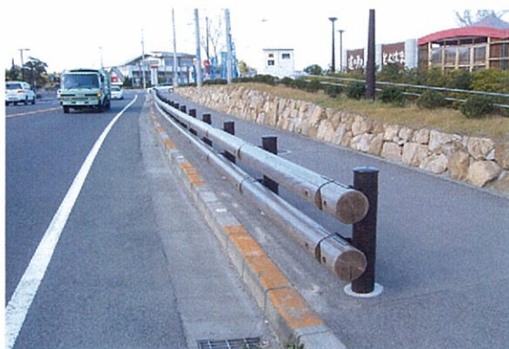
一般国道11号横断防止柵（道路事業）
