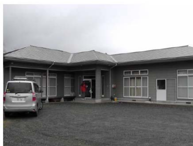
救護所を開設した陸前高田市竹駒地区の公民館です
