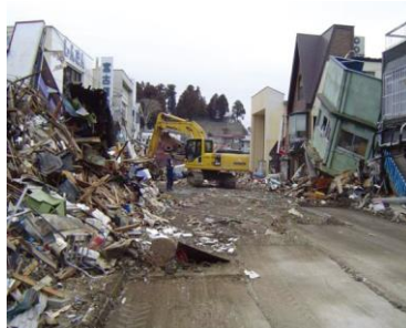
道路啓開の様子
