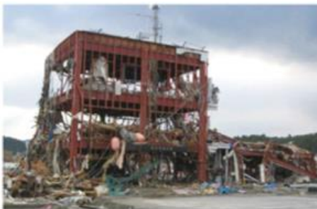
被災した庁舎
