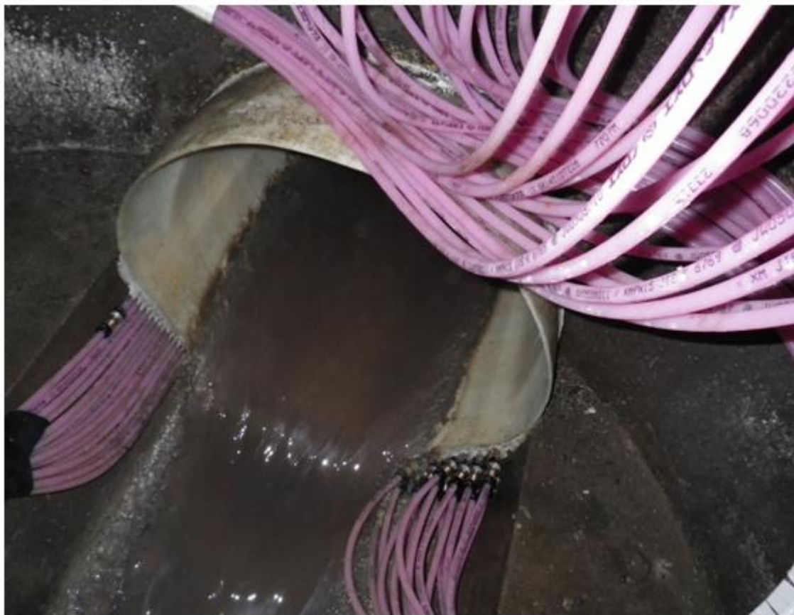
管口部の状況(新潟県十日町市)
