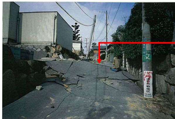
図参 1.1-⑤ 西宮市における盛土造成地の変動に伴う被害（その 2）
