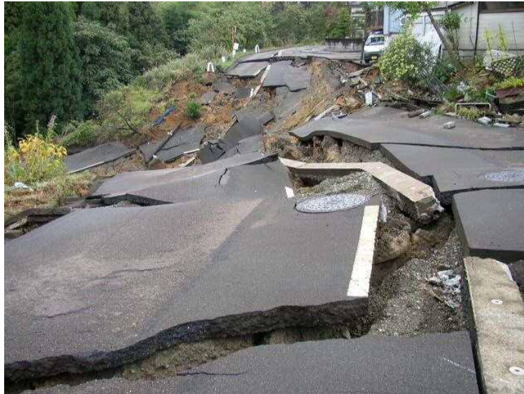
図参 1.1-⑦ 新潟県長岡市高町の盛土造成地の滑動崩落現象その 1
