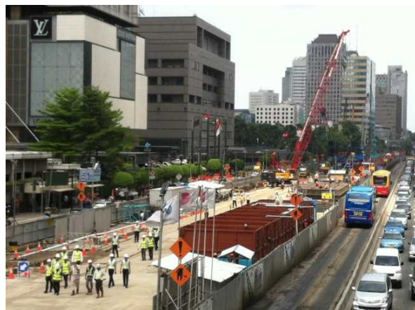
ジャカルタ日本大使館前の MRT 工事(三井住友建設)
