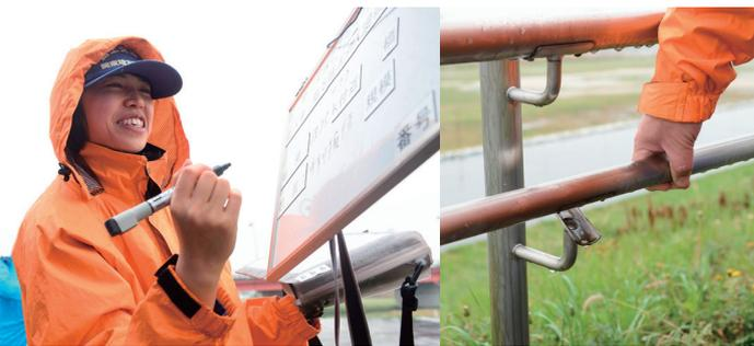
手すりの留め具の破損を発見。後日の修繕が必要のため、記録写真で掲示するボードに位置、状況などを詳細に記録。この点検は、ゴールデンウィーク前と学校が夏休みに入る前に実施する。
