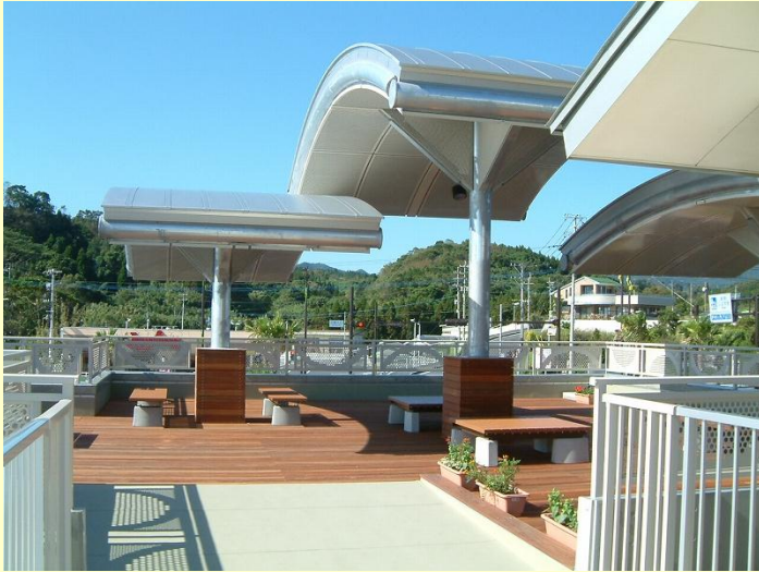
トイレ屋上展望台
