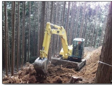
作業道の作設
