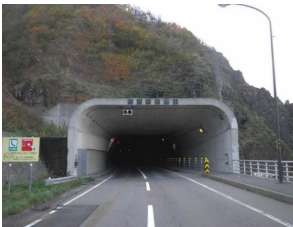
トンネル概観（起点側坑口）
