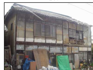
長期間人が住んでいない空家
