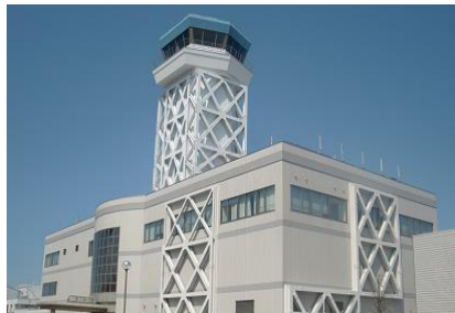
耐震フレームの設置により、管制塔等の倒壊を防止
