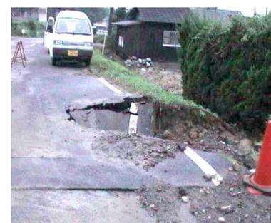
出水被害(道路陥没)
