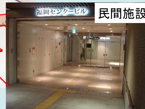
福岡センタービルとの接続部
