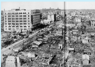
被災後の様子(東京都京橋)
