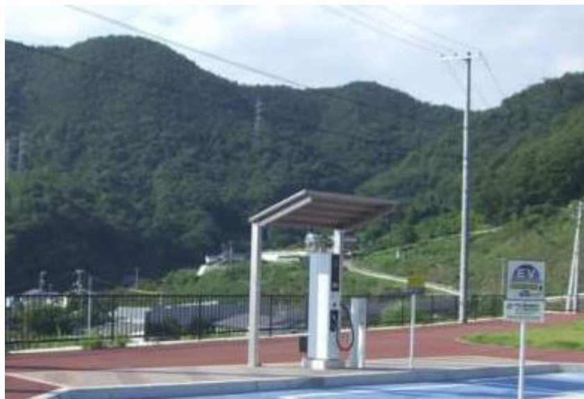
国道2号 道の駅みはら神明の里(広島県)
