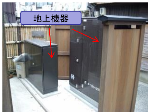
民地を活用した地上機器の設置
