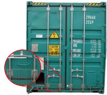
図 8.4 バルクコンテナの足掛け段
