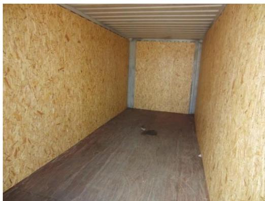
図 7.53 40 フィートコンテナをチップボードパネルで覆ったところ
