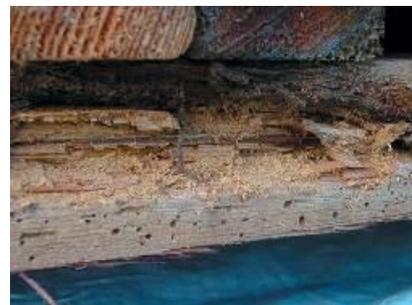
図 6.13 穿孔性昆虫による木の粉くず
