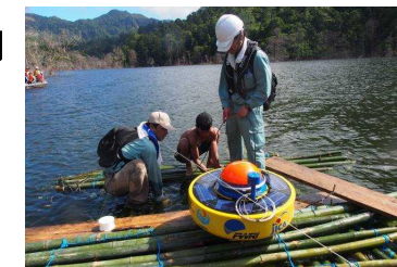
水位観測ブイの設置状況
