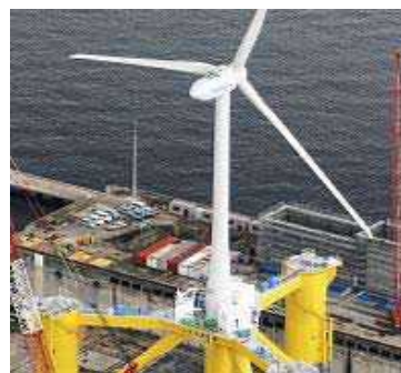
洋上風力発電設備 (H25.8現地設置)
