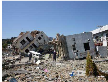
津波により転倒したRC造建築物
