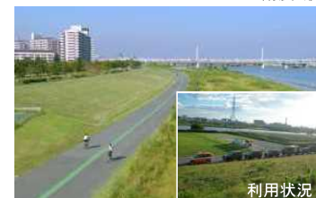
緊急用河川敷道路(荒川)
