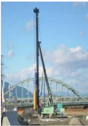
揖斐川施工状況
