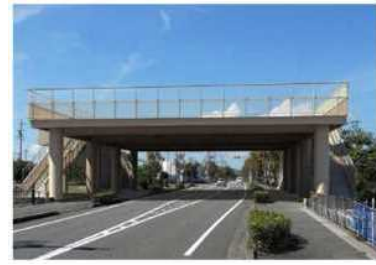
道路上の津波避難タワー (静岡県吉田町)
