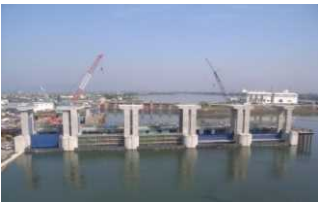
日光川水閘門 施工状況
