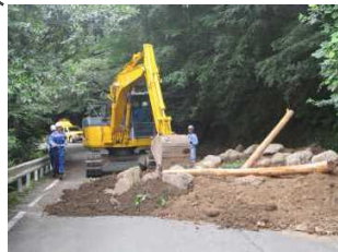
道路啓開訓練 (静岡県河津町)
