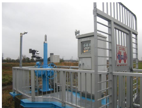
操作・分電盤等の例
