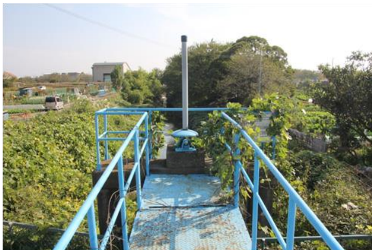
千疋排水樋管
