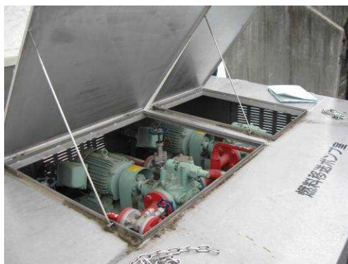
燃料移送ポンプ設置状況
