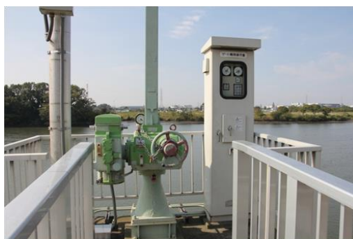
両方（手動・電動） 上口排水樋管
