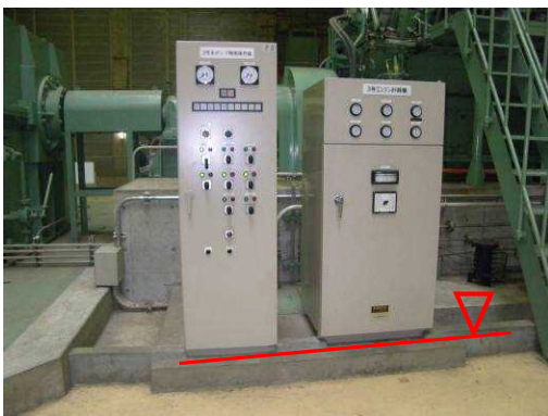
操作盤配置状況
