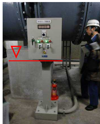
操作盤配置状況
