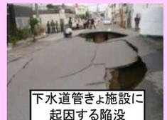
下水道管きょ施設に起因する陥没
