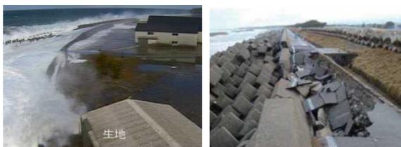
高波の越波状況（黒部市生地地区） 直立堤の倒壊状況（入善町五十里地区）
