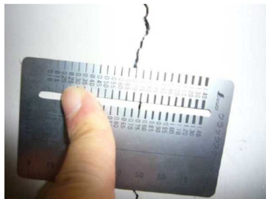
内壁：2階書庫の壁にひび割れが発生
