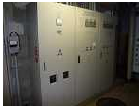
電気設備：動力設備に経年劣化が見られる
