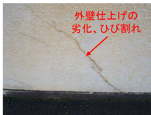
外壁：外壁仕上げの劣化及びひび割れが多数発生
