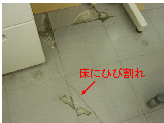
室内床：ひび割れや仕上げ材の劣化が見られる
