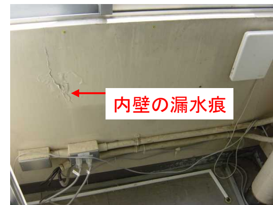
内壁：ひび割れより漏水が発生
