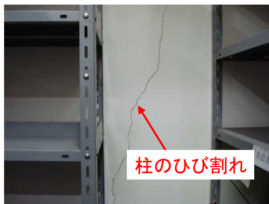
内部柱：1階証拠品庫の柱にひび割れが発生
