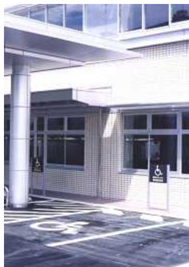
車いす利用者用 駐車場の整備
