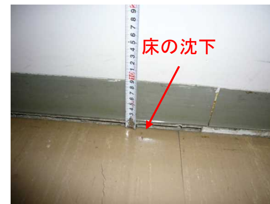
室内床：1階取調室の床スラブで沈下が発生
