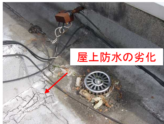
屋上：屋上防水の劣化し剥離し、屋内へ漏水が発生
