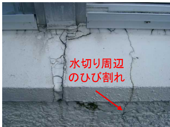
外壁：建具下の水切り等にひび割れが発生
