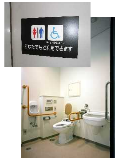
多機能トイレの整備
