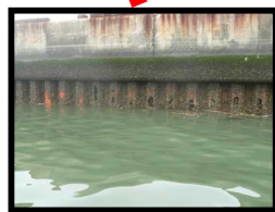
岸壁の老朽化状況
