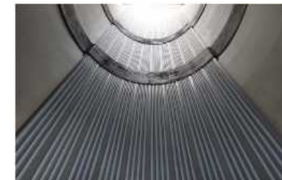
下水道管渠内の熱交換器
