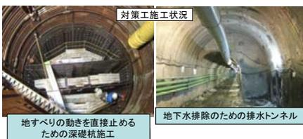
地すべりの動きを直接止めるための深礎杭施工
