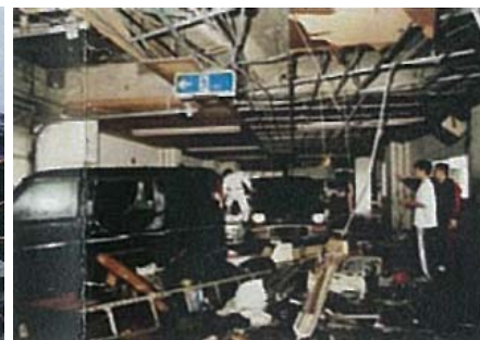
自動車販売店整備工場の被災状況
