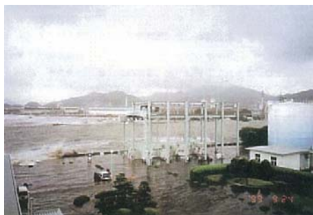
A電力の浸水状況
