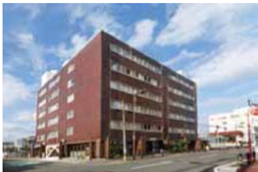
山王マンションの外観
