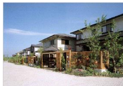
町家を現代風にアレンジした「新町家」(無電柱化) <京都府光台>
