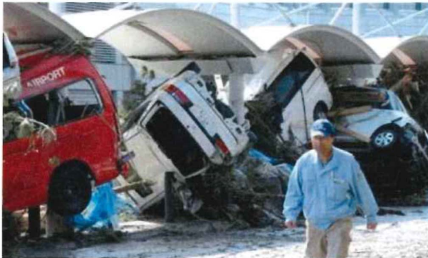
歩道ルーフが車両捕捉機能を果たした事例（東日本大震災時の仙台空港）
