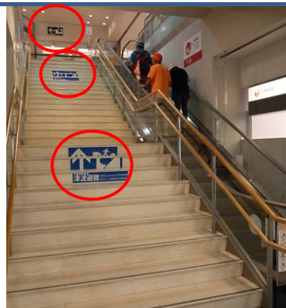
1F～2F中央階段にある 3箇所の避難誘導
