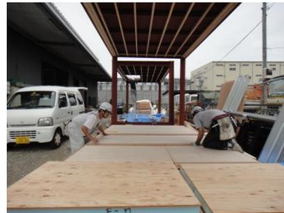
断熱材を挟んだ床パネルを設置
