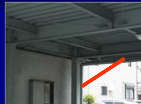
・弾塑性履歴型の構造特性に粘性減衰を加えると応答を効果的に抑制できる
