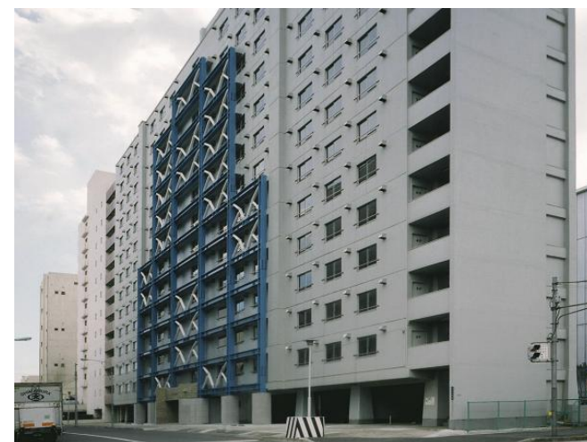
外側耐震補強
