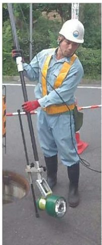
管口カメラ(スクリーニング調査)
