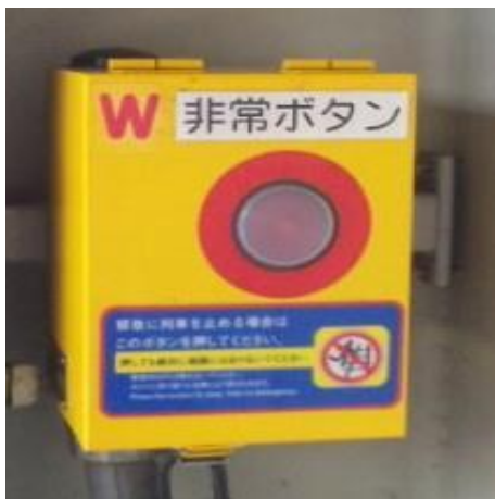
ホーム非常ボタン
