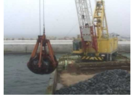
図 V-2.20 中詰石の投入状況
