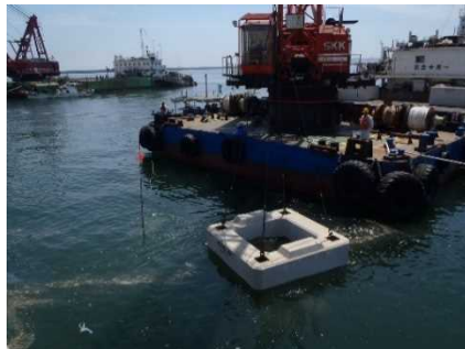
図 V-2.19 サブプレオフレームの設置状況
