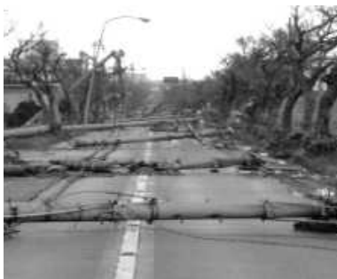
<電柱の倒壊による道路閉塞>
