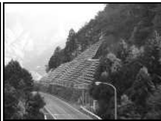
<斜面崩落防止対策>
