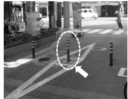
〈進入抑制策の例(ライジングボラード)〉
