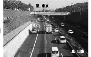
■対策実施中(非常駐車帯設置状況)
