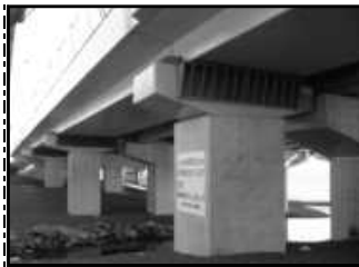
<橋梁の耐震補強>
