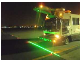
(基本施設点検実施状況)
