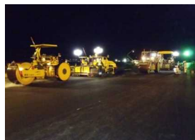
(老朽化した滑走路舗装の改良)
