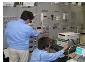
(航空保安施設点検実施状況)
