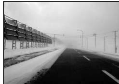
防雪柵の設置
